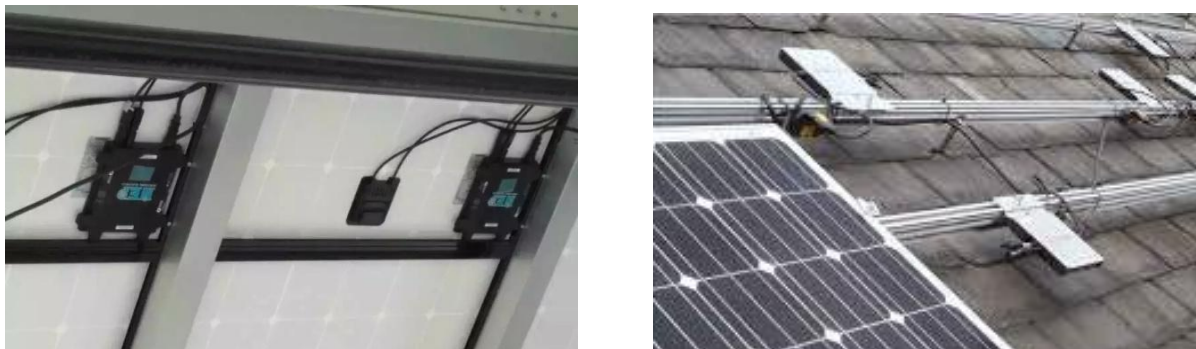
Figure 25: exemples de fixation des micro-onduleurs
